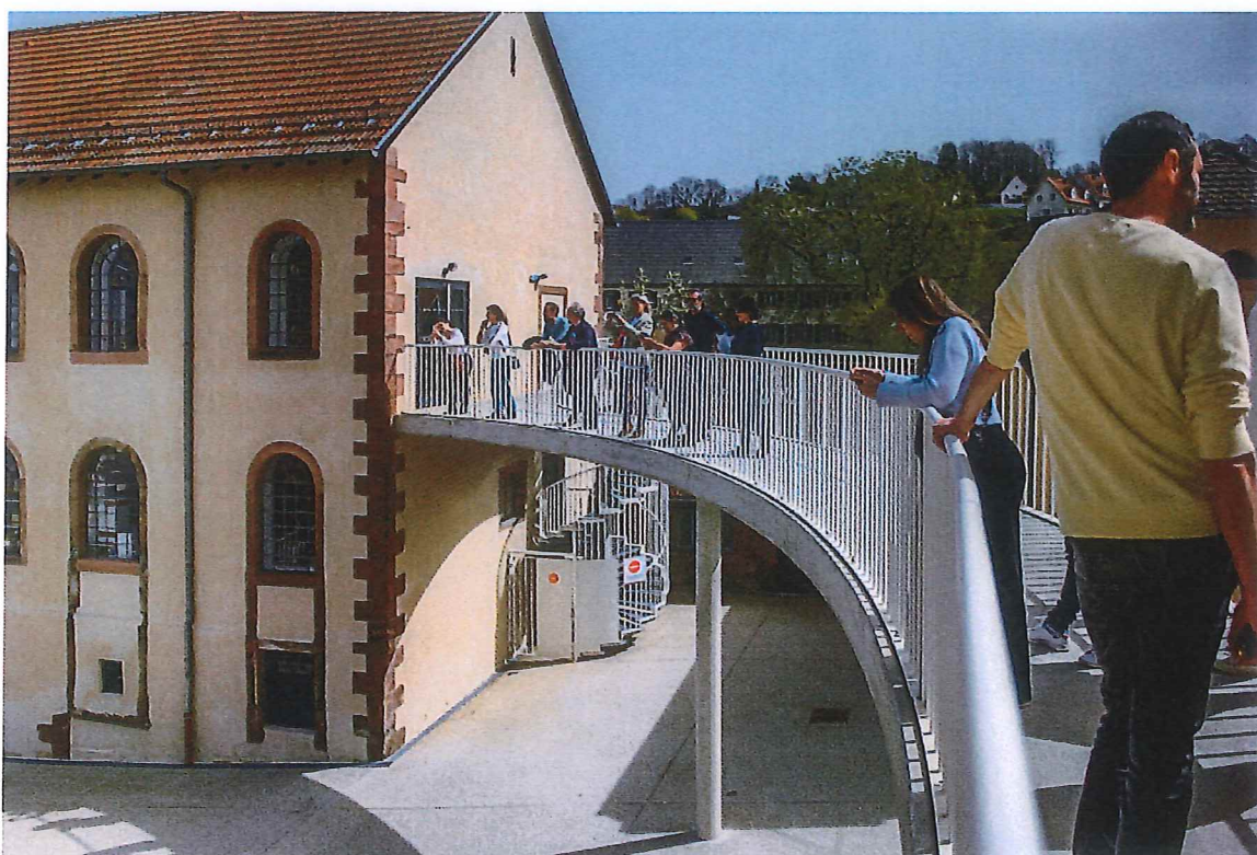
Une passerelle relie le Musée du Verre à l'atelier historique du CIAV (Crédits photo : CIAV)
