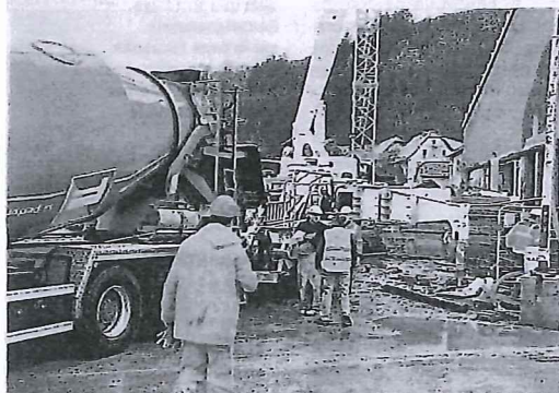
La transformation du site verrier de Meisenthal, chantier à plus de 14 M€, se poursuit. Photo RL
