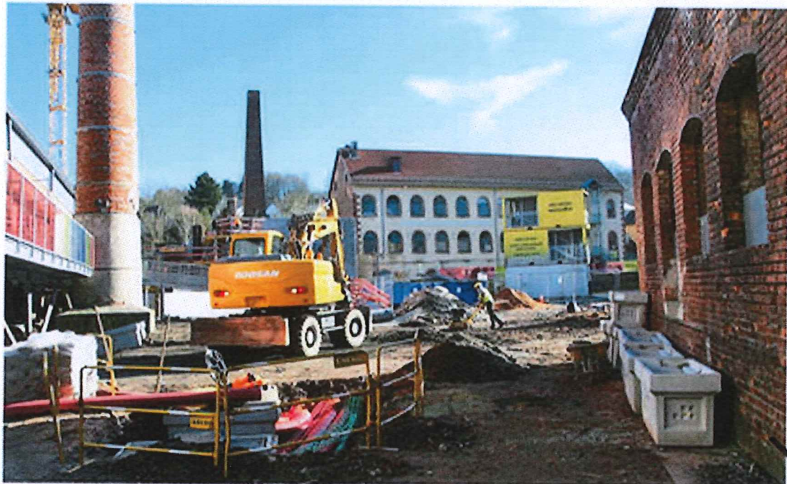
La cour du site verrier de Meisenthal, vaste chantier. Photo RI
