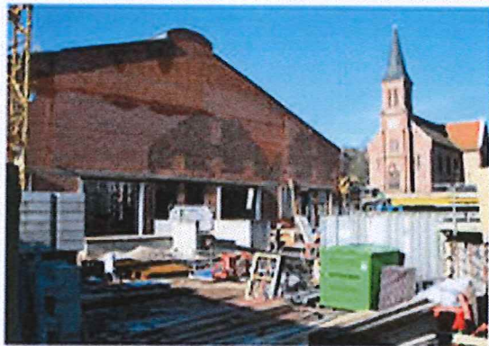
Le pignon de la halle verrière encore intact jeudi. Le lendemain, de nouvelles démolitions commencent. Photo RI
