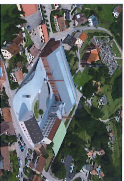
Vue aérienne du site verrier de Meisenthal. Les anciens bâtiments sont reliés par une « vague » de béton ; le nouveau bâtiment d'exposition de 1300 m 2 est relié au site existant par une « vague » de béton ; les autres constructions appuient sur le socle de la Halle Verrière (qui n'est pas visible sur l'image) et du cristal (en noir) de la Halle Verrière (qui n'est pas visible sur l'image).
