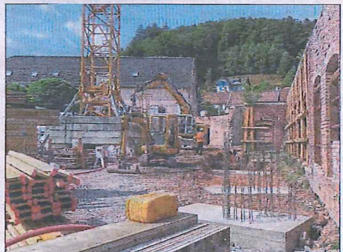
Les bases du voile géant, sur lequel le public pourra marcher, doivent être solides. Photo RL
