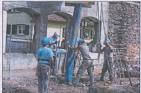
Les ouvriers coulent les fondations du futur voile géant, qui recouvrira la cour du nouveau site verrier. Photo RL
