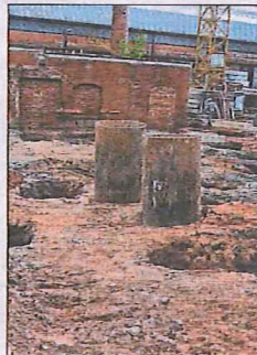
Des trous géants sont creusés pour les fondations.
