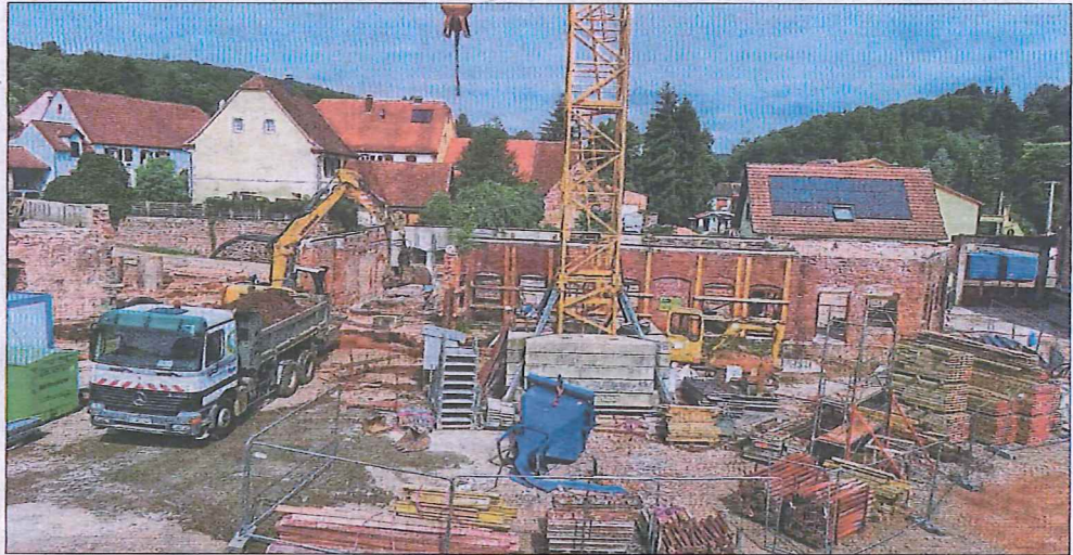
Le chantier a pris une autre tournure sur le site verrier de Meisenthal. Photo RL
