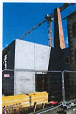
Les nouveaux ateliers du CIAV prennent forme. Photo RI
